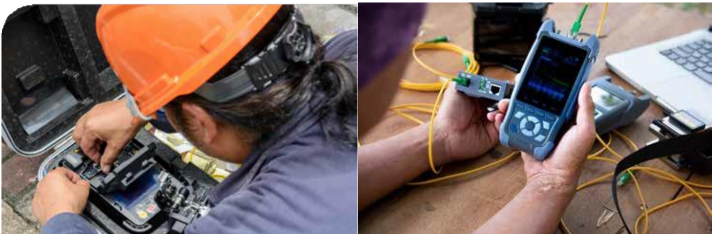
Figuur 1: links: lasapparaat voor glasvezel - rechts: een optische tijdsdomeinreflectometer (OTDR)
